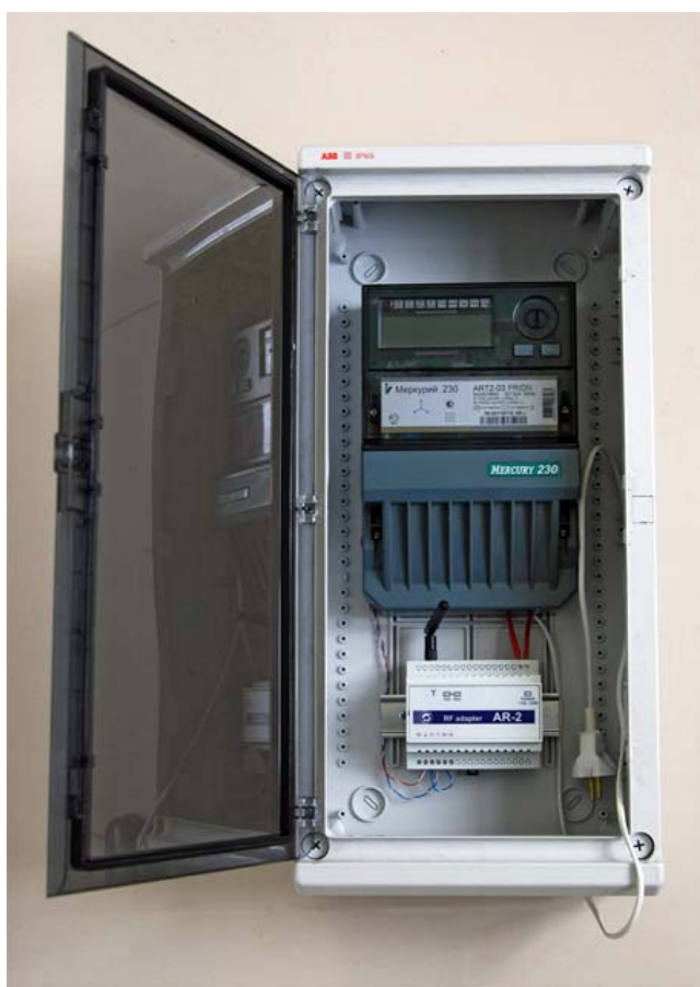
Рисунок 6. Схема беспроводного опроса счетчика Меркурий 230.
