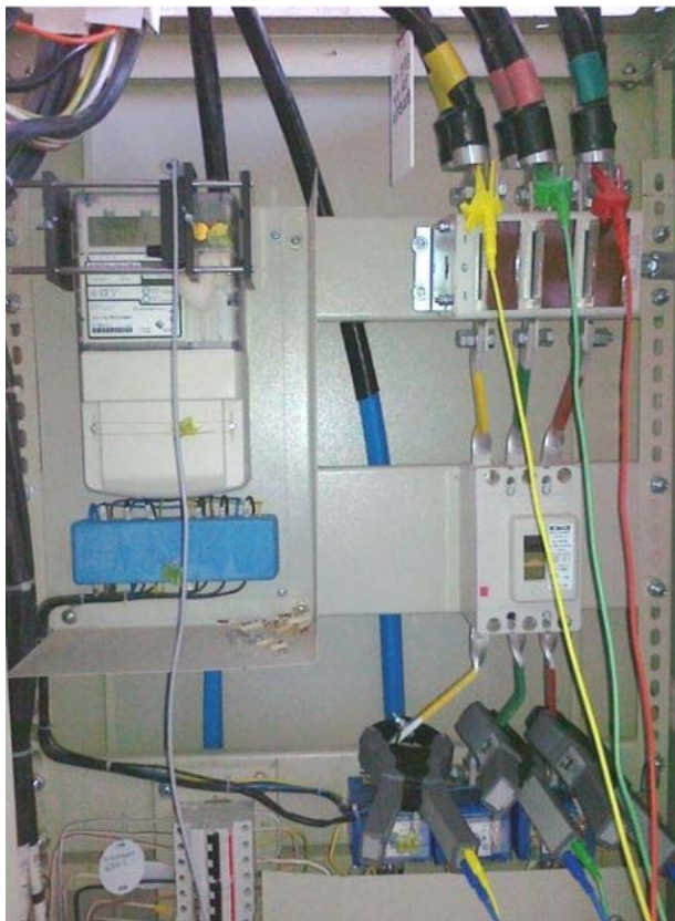
Рисунок 1 - Подключение прибора при проверке ИК
